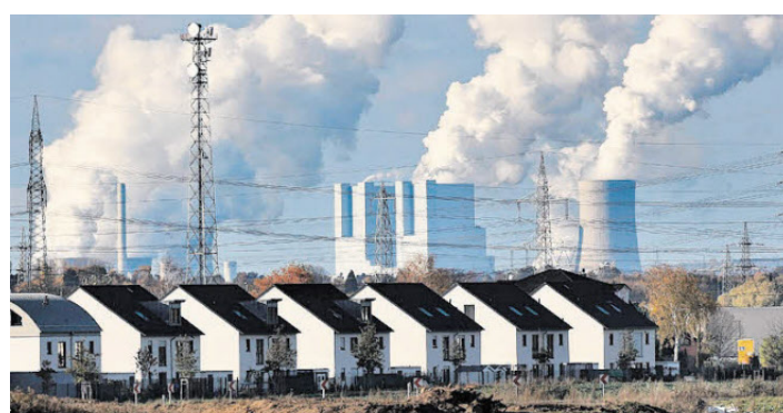
RWE-Kraftwerk Neurath im Rheinischen Revier
